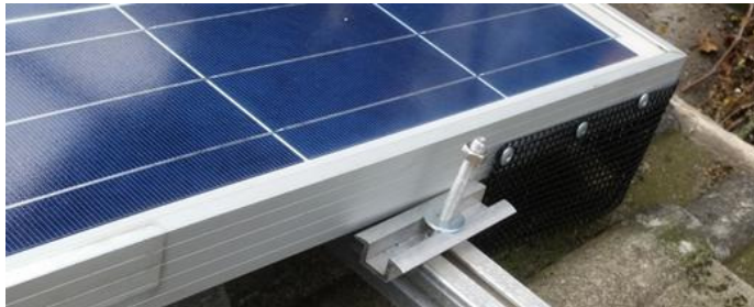
Gaas bevestigd met parkers rondom het zonnepaneel
